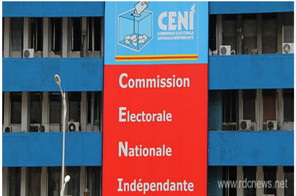
Bâtiment de la CENI-RDC
